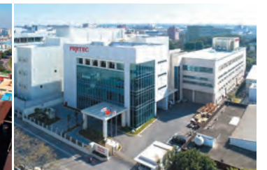
FUJITEC TAIWAN CO., LTD.
