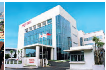
FUJITEC TAIWAN CO., LTD.
